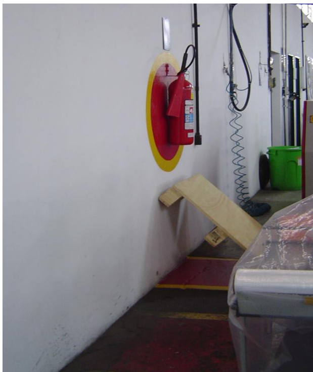
Figura 31: Objeto dificultando acesso ao extintor de incêndio.
